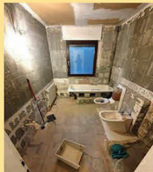
Das Bad vor der Sanierung
