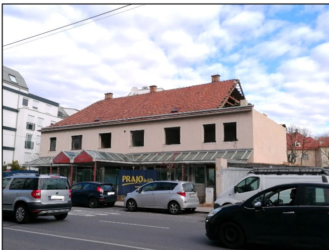
Renovierung oder Abriss? Das Gebäude in der Siemensstraße 7 im Februar 2024
