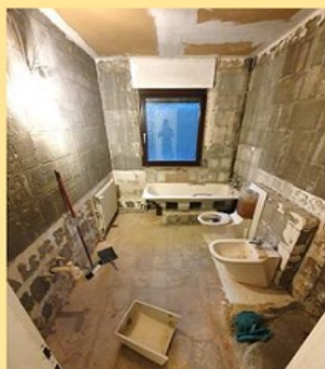
Das Bad vor der Sanierung
