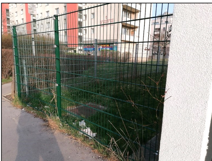
Die Fahrradleiche wurde endlich entfernt. Jetzt müßte noch der Müll hier weggeräumt werden!
