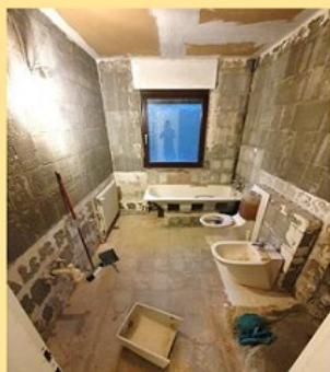
Das Bad vor der Sanierung
