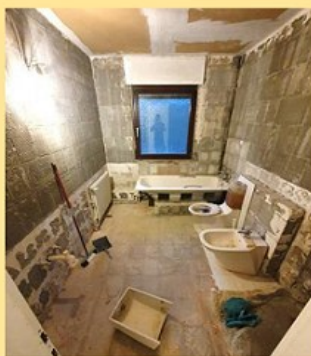
Das Bad vor der Sanierung
