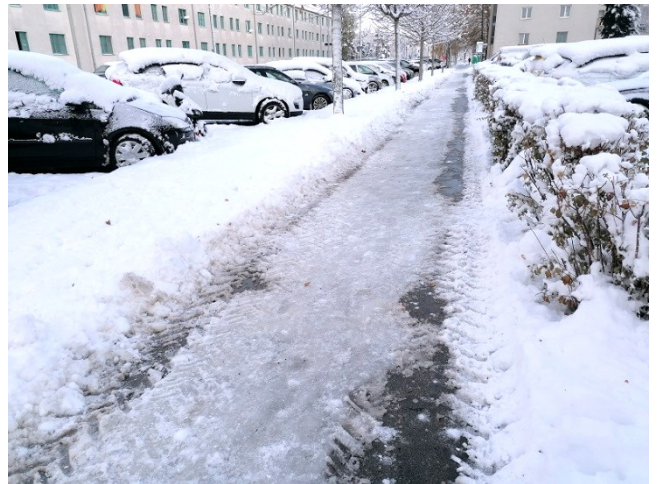
Der Gehsteig vor den Stiegen 22 - 23 (bei der Nebenfahrbahn in unserer Wohnhausanlage) am Tag nach dem Schneefall – eine Eisbahn
