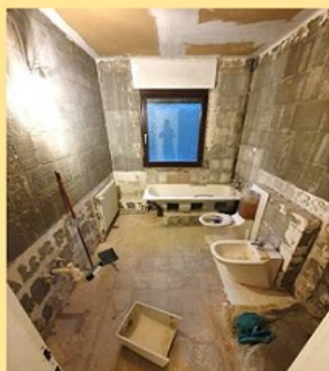
Das Bad vor der Sanierung
