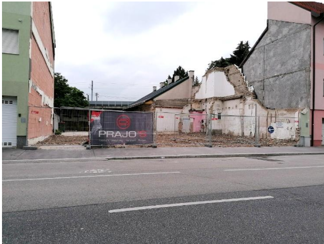
Die Reste nach dem Abbruch
