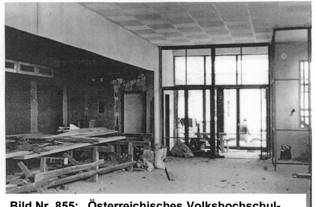
Bild Nr. 855: „Österreichisches Volkshochschularchiv“: Umbau des Volkshaus Groß Jedlersdorf 1962
